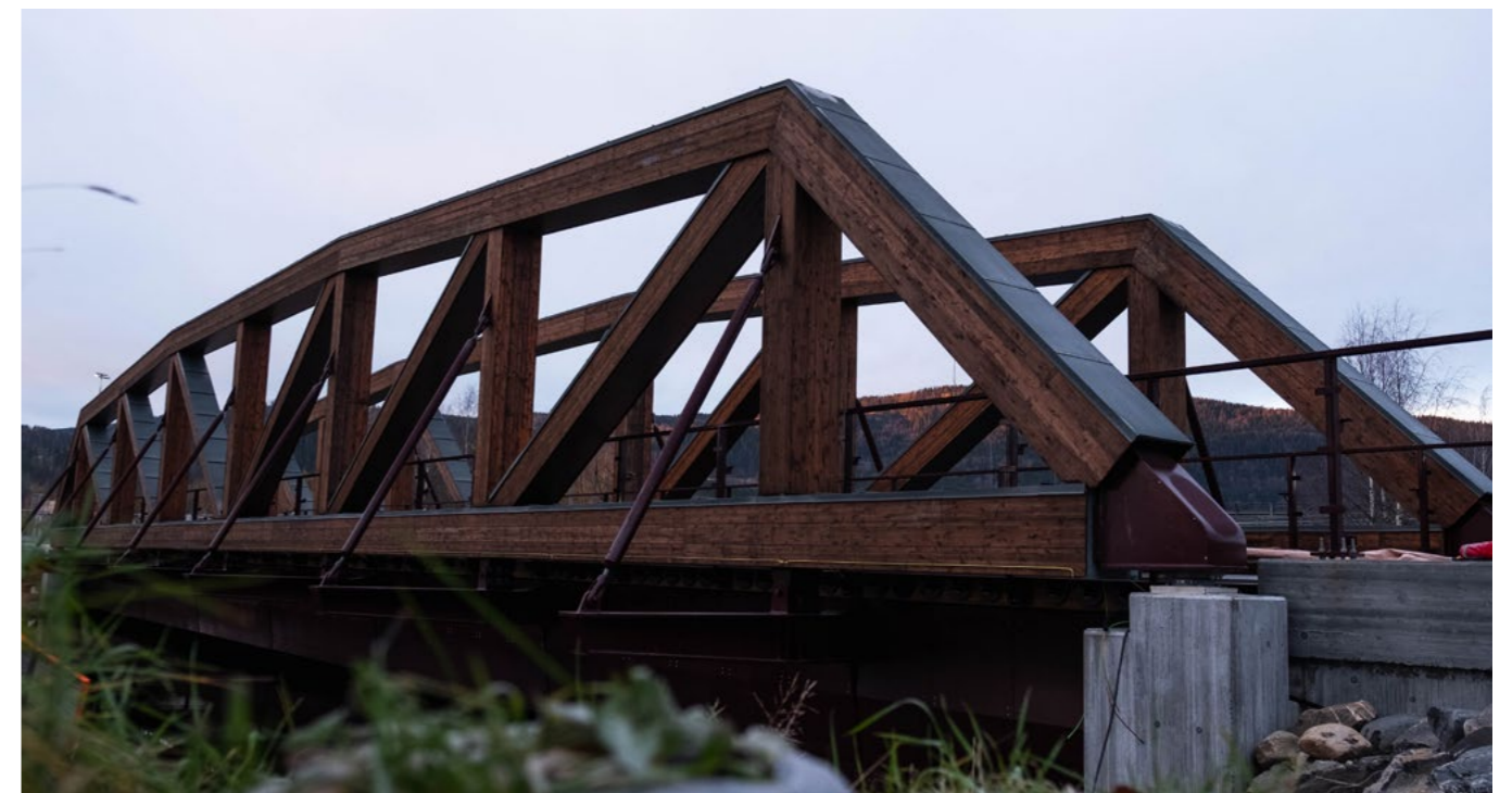
2024 byggde Lillehammer kommune en helt ny fackverksbro för gående och cyklister tillverkad i limträ från Moelven.
