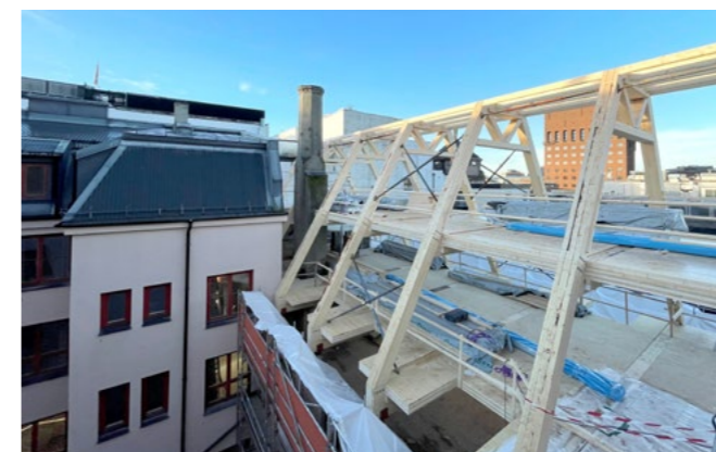
Högst upp i byggnaden på Øvre Vollgate 11 byggs två nya våningar i limträ från Moelven.
