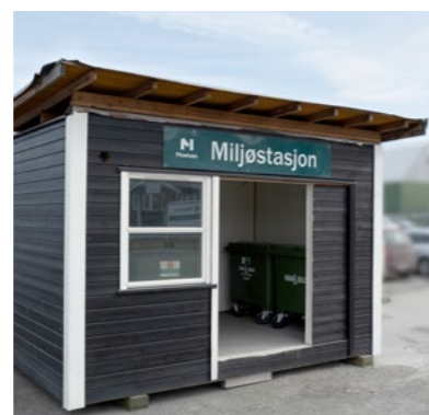
Modulär miljöstation hos Moelven Byggmodul AB. Avfallshantering handlar inte bara om stora volymfraktioner från industrin. Att enkelt kunna sortera mindre fraktioner från kontorsbyggnader och andra utrymmen ger en tydlig signaleffekt och gör att alla medarbetare aktivt kan delta i arbetet med ordning och reda.
