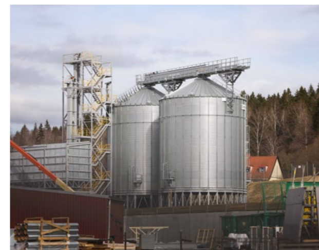
Lagringssilos för träpellets hos Moelven Pellets AB i Karlskoga. All restråvara används inte för den egna bioenergiproduktionen. I både Norge och Sverige har Moelven anläggningar som förädlar restråvara från träindustrin till pellets för extern försäljning.
