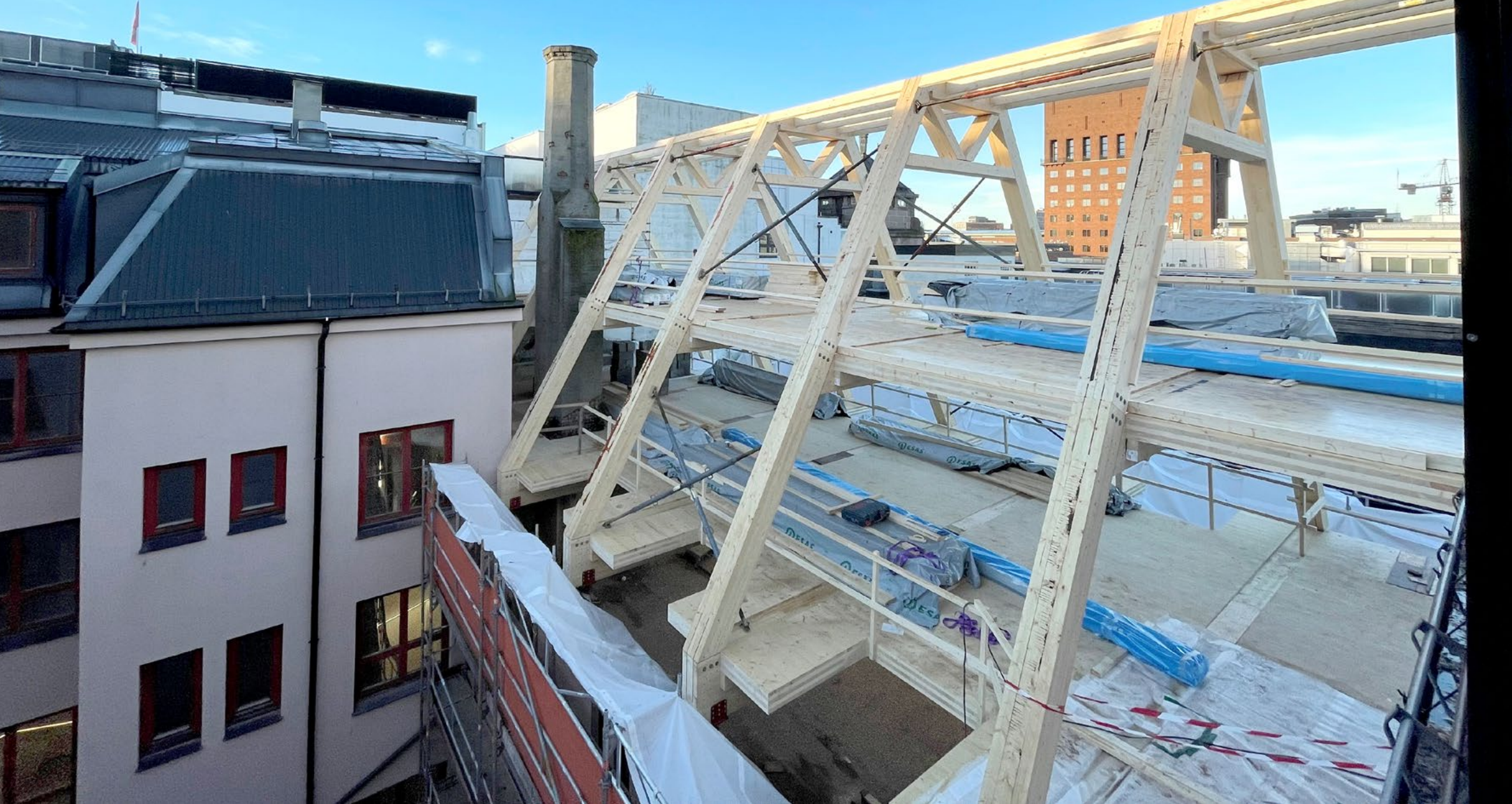
Tore Olsen Haglund, projektledare på Moelven Limtre AS, framhåller limträ som ett lämpligt material för höghustillbyggnader tack vare den låga vikten i förhållande till hållfastheten. – Man sparar både utrymme och material genom att utgå från befintliga byggnader.
